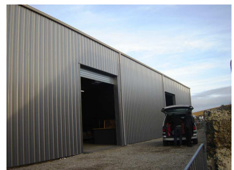
Nouvel hangar de 1500 m 2
